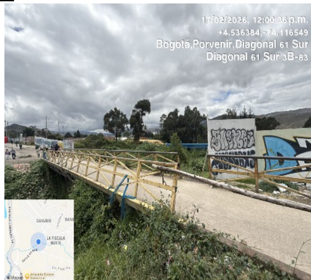
Fotografía No. 6: Área de interés a intervenir
